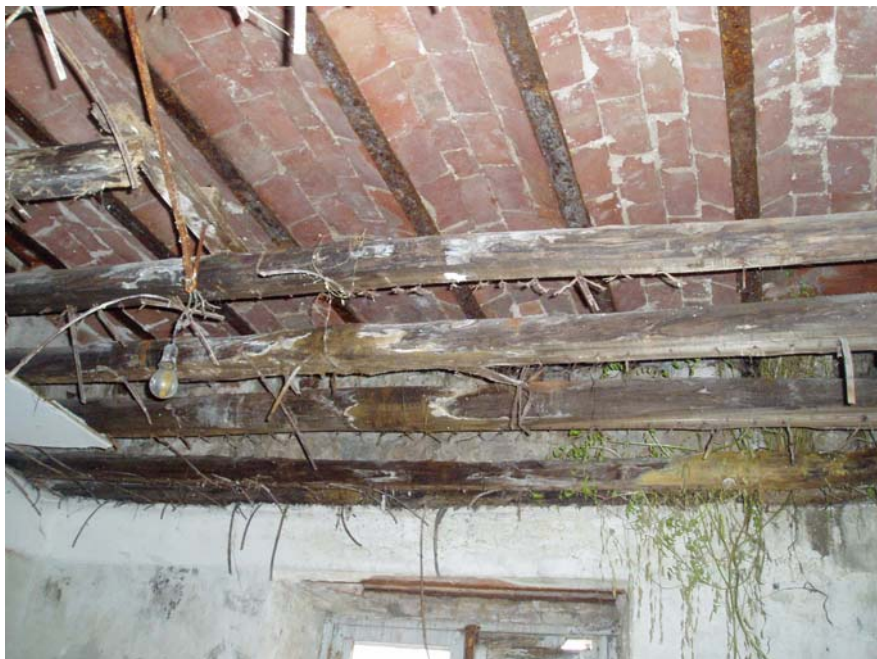
Fotos de la Casa de la dirección
